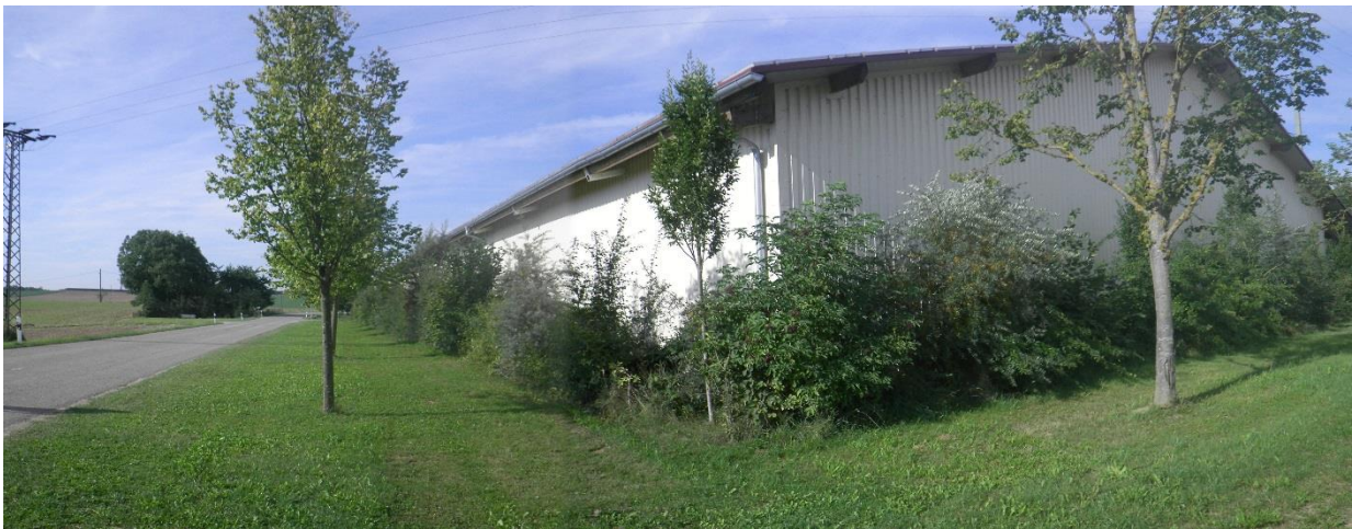
Abb. 5. Blick in Richtung Süden entlang der Ortsverbindungsstraße Petting-Theissing auf eine der bestehenden Lagerhallen und deren Eingrünung
