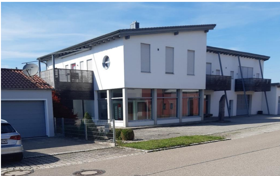
Abb. 5 Wohn- und Betriebsgebäude auf Flurnummer 2740/20
