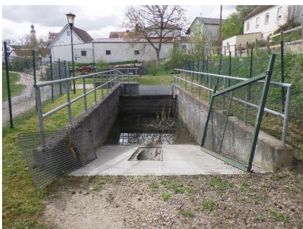
Abb. 4 Rückhaltebecken auf Flurnummer 2948/180
