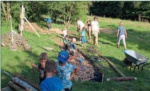
Jung und Alt arbeiten fleißig an der Anlage des Barfußweges und der Weitsprungbahn.
